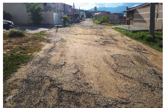
F4-Vista parcial da rua.
