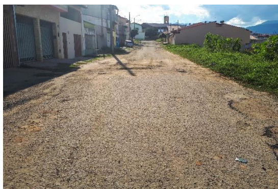
F5 - - Vista parcial da rua
