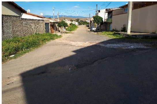
F1-Vista do início da rua de uns dos lados.
