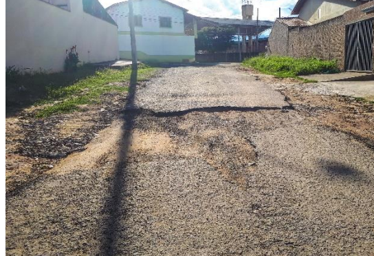
F6-Vista parcial da rua.
